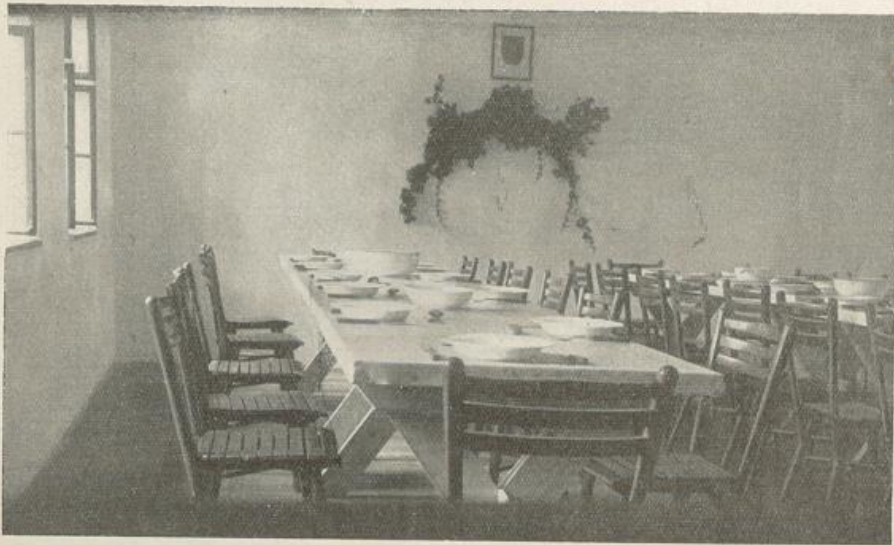
Städtisches Altersheim — „jetzt“ Robert Forstner, Photograph, Eisenstadt (Burgenland)
