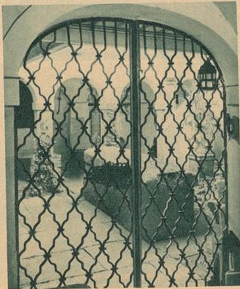
Blick durch alles Gitterwerk in den Hof mit römischem Sarkophag.
