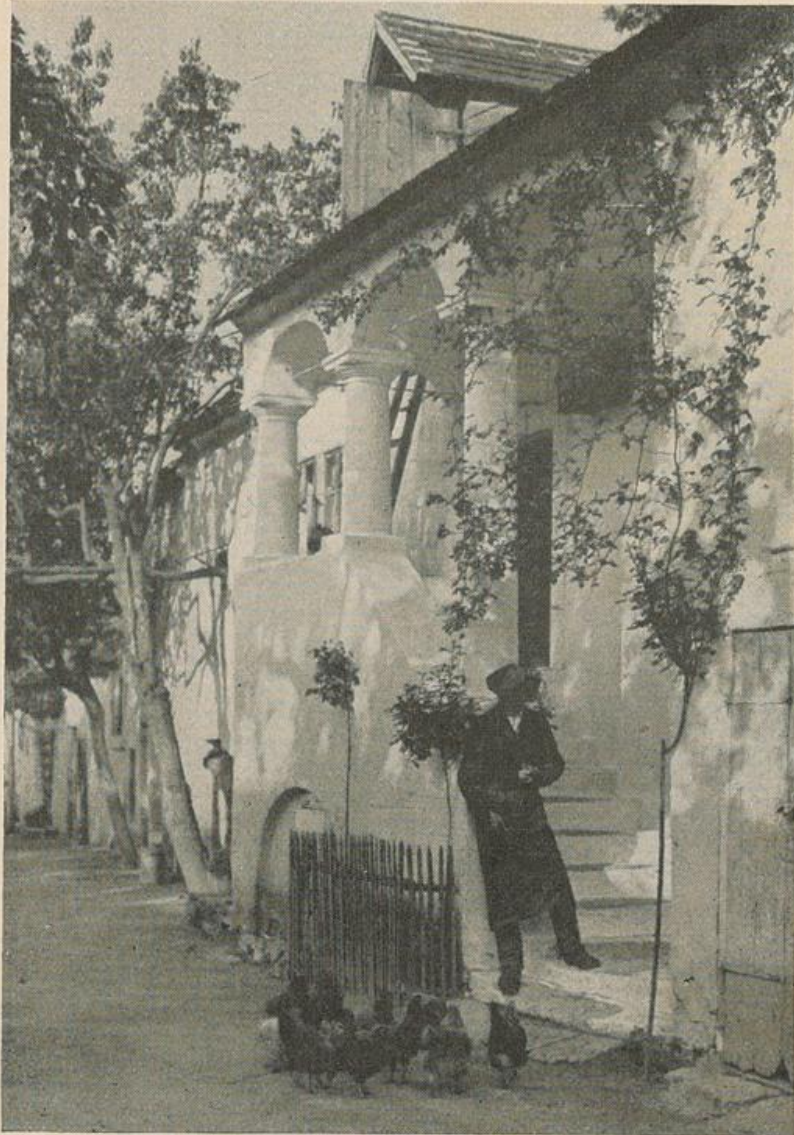
Vorhallenhaus in Mörbisch am Neusiedler See.
